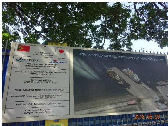
人と貨物を分けるために、フェリー・ターミナルの移設建設が行われている
